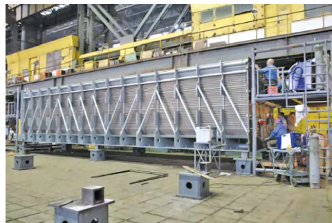
Сварка и контроль
