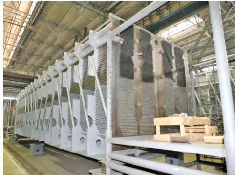
Установка труб в модуле
