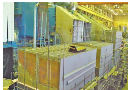
Установка укрупненных модулей на опоры
