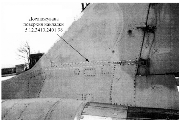
Рис. 1. Зона візуального контролю стикових накладок кріплення кіля до підкільової надбудови літаків типу МіГ-29
