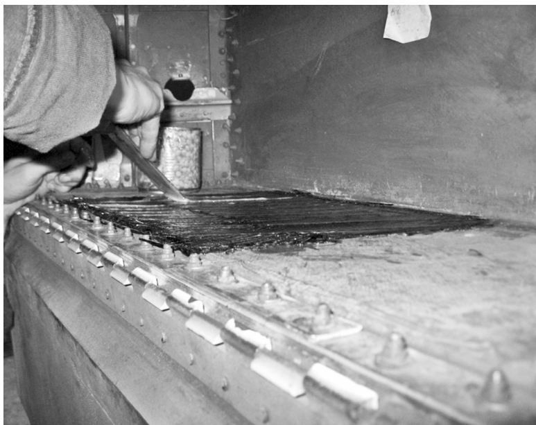
Рис. 7. Нанесение клея ВК-9 при установке слоев ремонтной накладки
