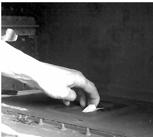
Рис. 12. Установка пенопласта при ремонте трубчатого заполнителя
