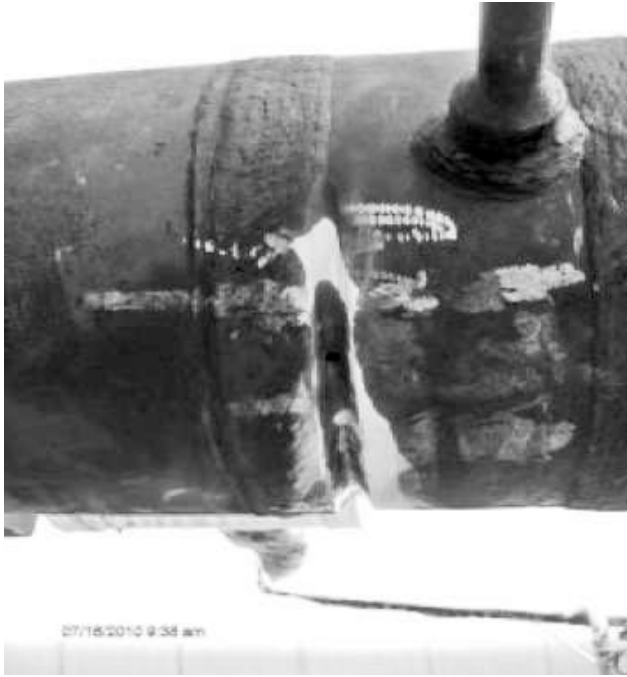
Рис. 3. Підготовка механічним способом ділянки кільцевого шва з непроваром в корені для подальшого ремонту зварюванням
