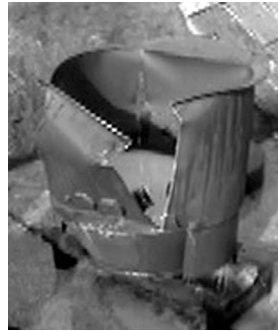
Рис. 4. Верхняя часть трансформатора до, во время и после подрыва заряда ВВ
